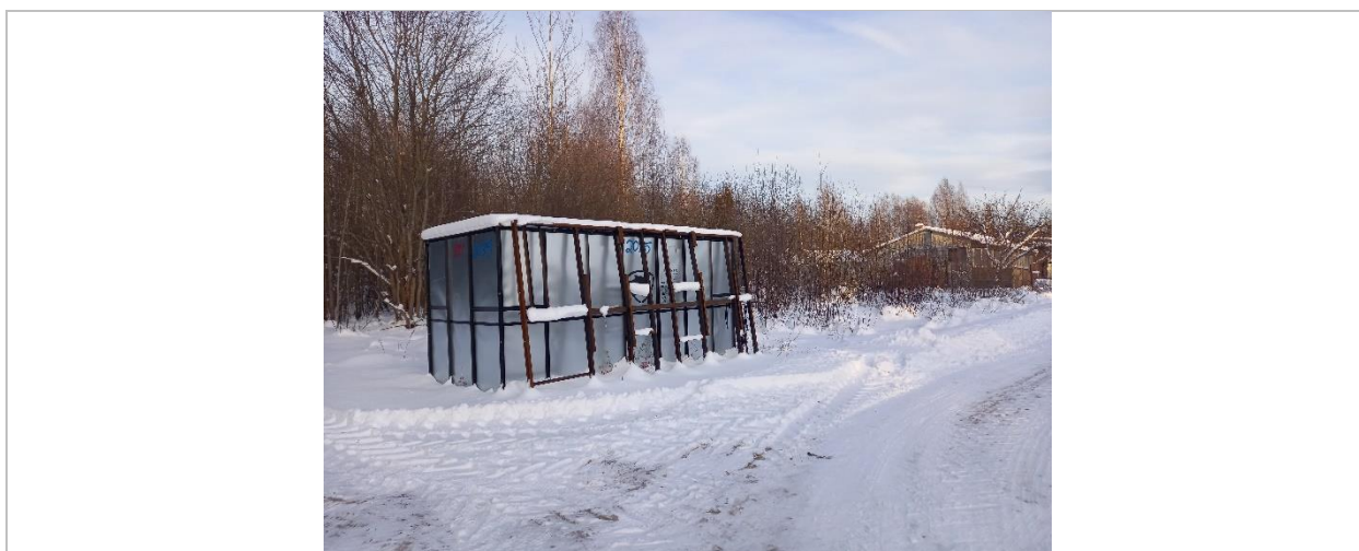
Skats uz vērtējamo objektu
