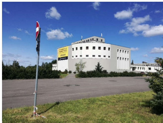
41. attēls. Esošā autostāvvietas
