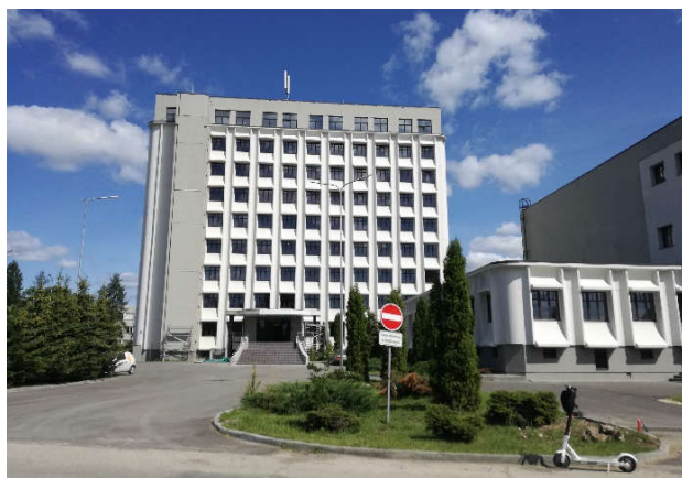
5. attēls. Bijusī Ogres trikotāžas kombināta administrācijas/viesnīcas ēka (skats no Ikšķiles ielas)
