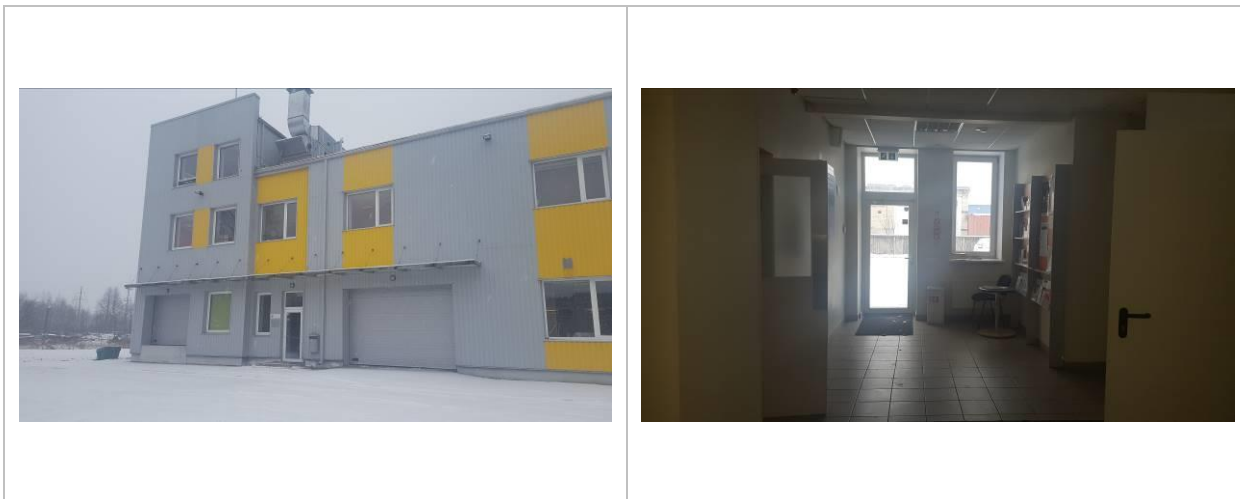
Skats uz vērtējamo objektu un nedzīvojamās ēkas iekštelpas
