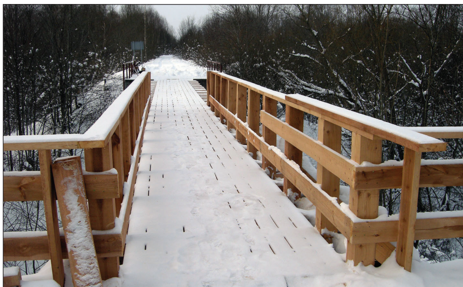
Atjaunotā pāreja pa dzelzceļa tiltu
