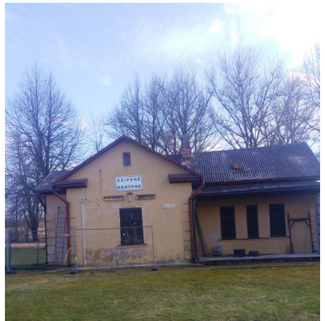
Keipenes dzelzceļa stacijas ēka vēl vecajā veidolā
