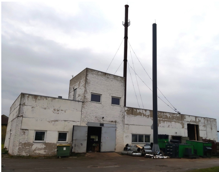
Ķeipenes ciema katlu mājā jau sākušies rekonstrukcijas darbi
