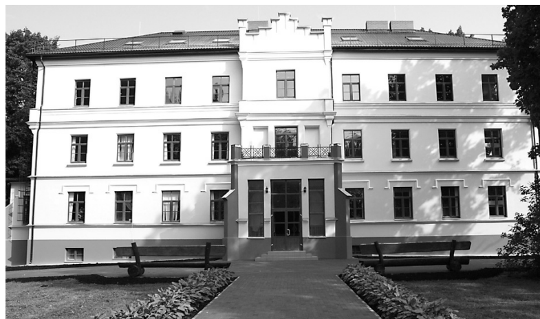
Taurupes vidusskolas ēka pēc rekonstrukcijas
