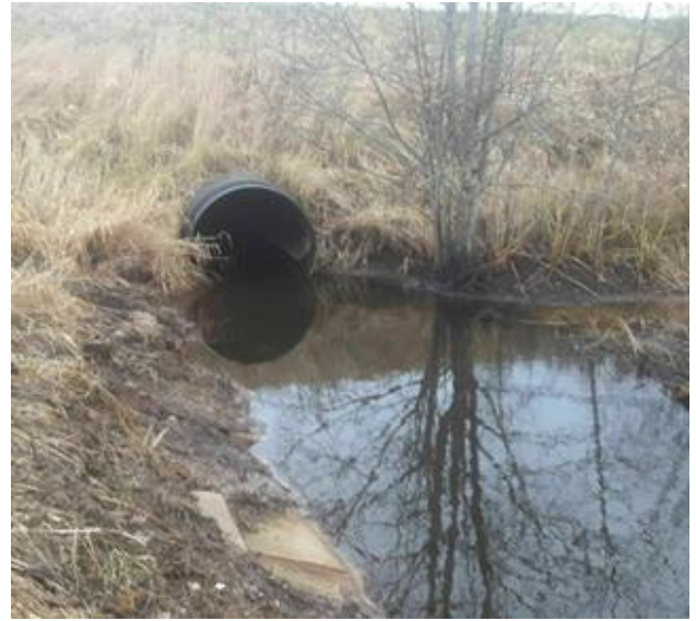
2.att. Grāvja ŪSIK 412345492:2 ceļa caurteka
