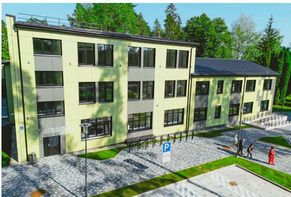
Pārbūvētā ēka Suntažu ielā 2, Ogrē
