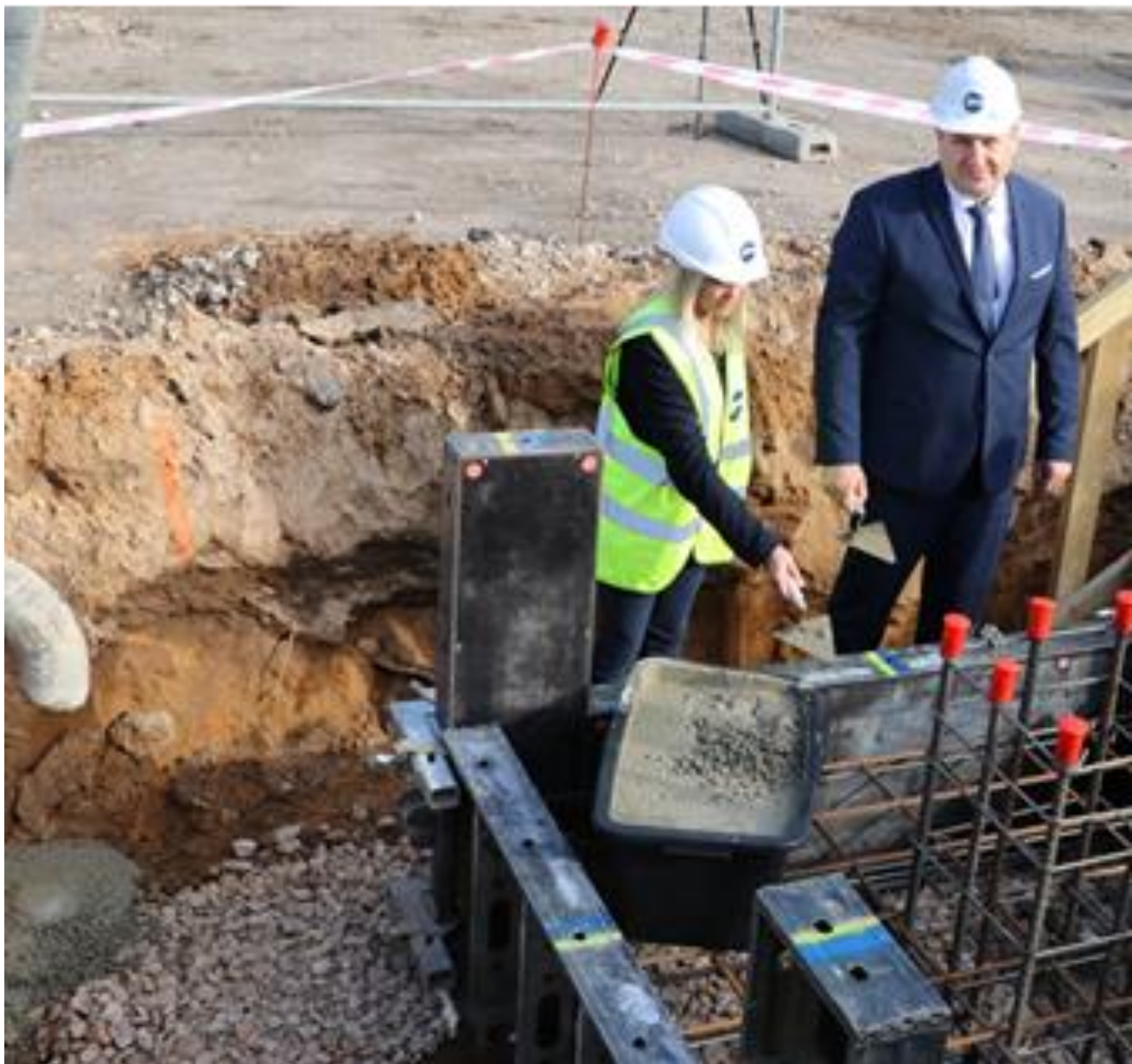
Ogres novada pašvaldības domes priekšsēdētājs Egils Helmanis un SIA "Arčers" valdes locekle Maija Baltgalve elektronisko sistēmu ražošanas ēkas Akmeņu ielā 74, Ogrē, pamatos iemūrē kapsulu ar vēstījumu nākamajām paaudzēm
