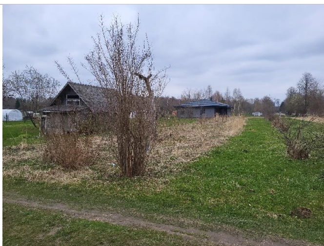
Skats uz vērtējamo objektu
