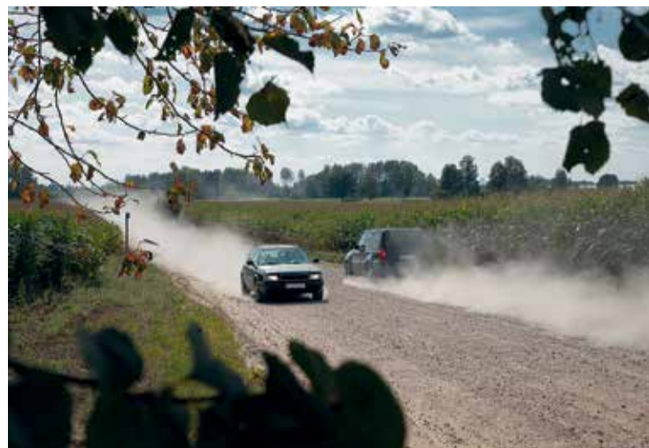
Autoceļš Lielvārde - Rozītes ar grants segumu.
