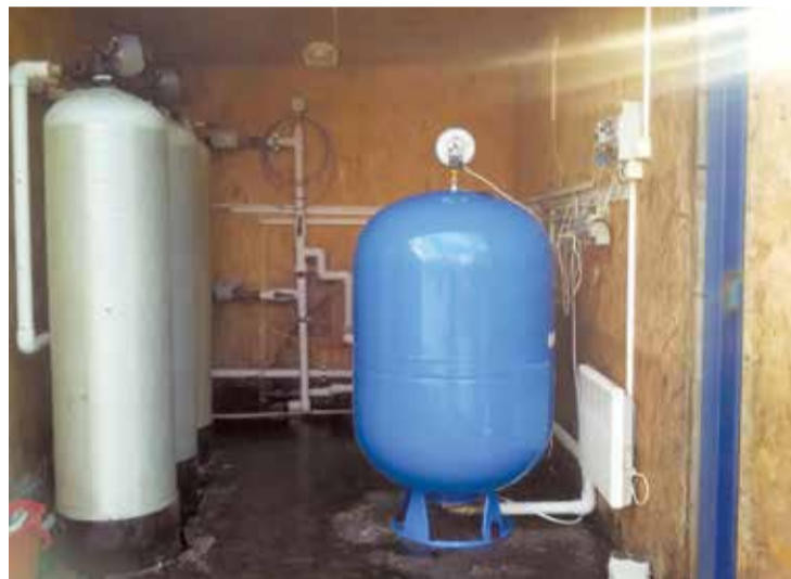
Dzelmju ciema atdzelzēšanas stacijas iekārtas pēc rekonstrukcijas.
