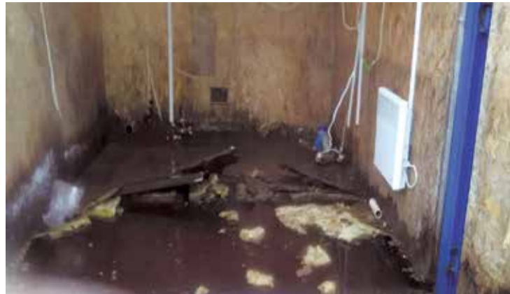
Dzelmju ciema atdzelzēšanas stacijas iekārtas demontāžas process.
