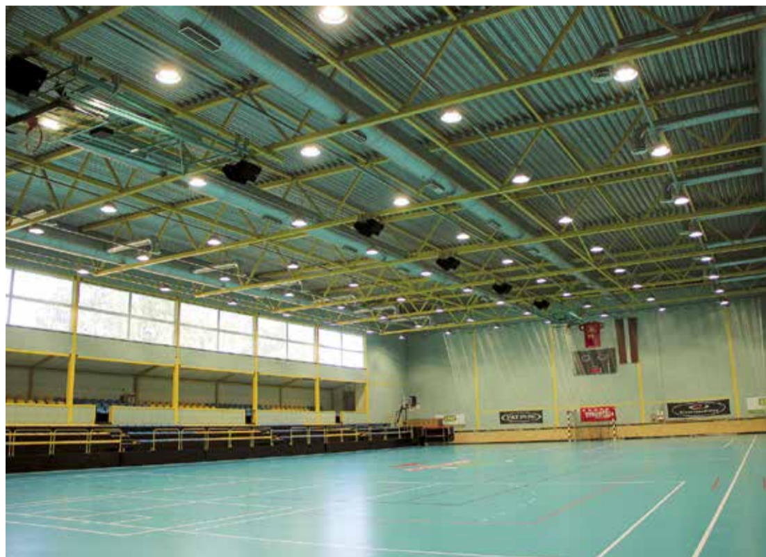
Lielvārdes novada Sporta centrā lielajā zālē 2018. gadā nomainīts apgaismojums. 2019. gadā varam secināt, ka jaunās lampas patērē mazāk elektrības un ātrāk ieslēdzas. Foto: Keita Rožāne
