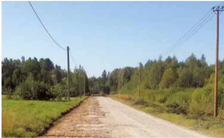
Noņemts vecais segums pašvaldības autoceļa "Pamati-Lejasplošas" posmam. Dzintara Laganovska foto
