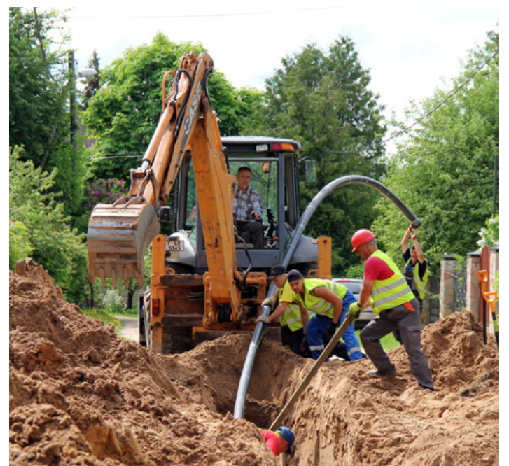
Ūdensvada un kanalizācijas izbūve Upes ielā. Beatas Kempeles foto.
