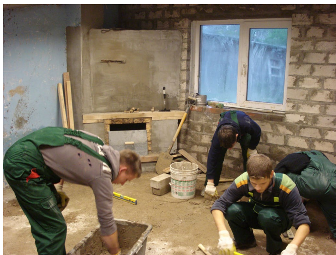
Jaunie remontstrādnieki apgūst būvdarbu pamatiemaņas.
