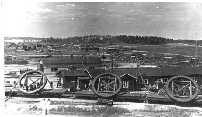
Generatoru rotoru Ķegumā
