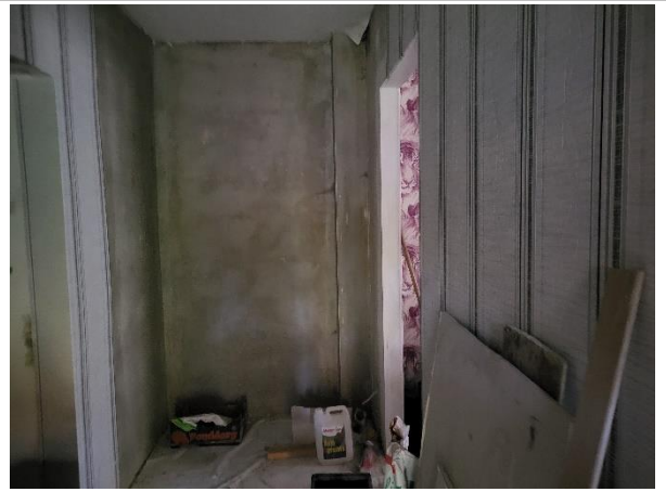
Ar vieglas konstrukcijas starpsienu atdalīts gaitenis
