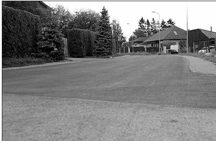
Šobrīd jau gandrīz pabeigta Rīgas ielas asfaltēšana no Pils ielas līdz Elkšņu krustojumam.
