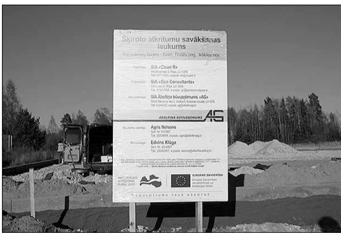
Oktobra sākumā Ikšķiles novadā tika uzsākta šķiroto atkritumu savākšanas laukuma izbūve.
