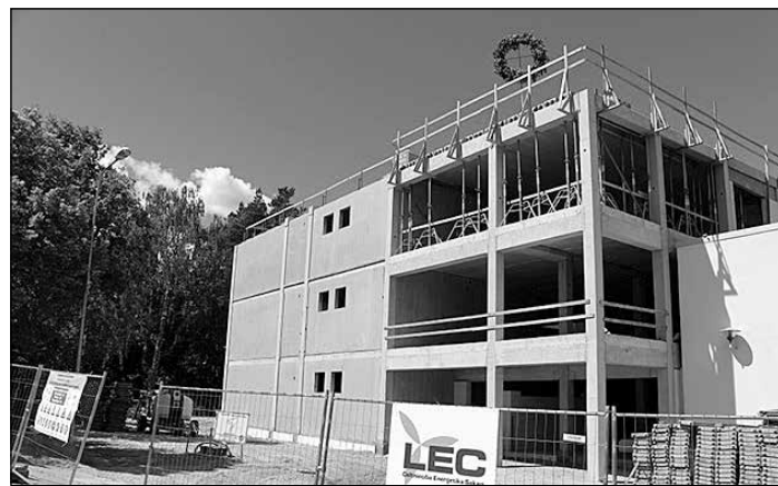
Nepilnu trīs mēnešu laikā būve no pamatiem sasniegusi trīs stāvu augstumu.
