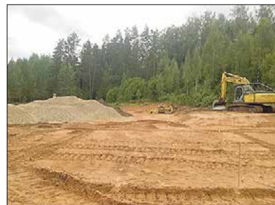
Stāvvietas būvlaukums darba procesā.
